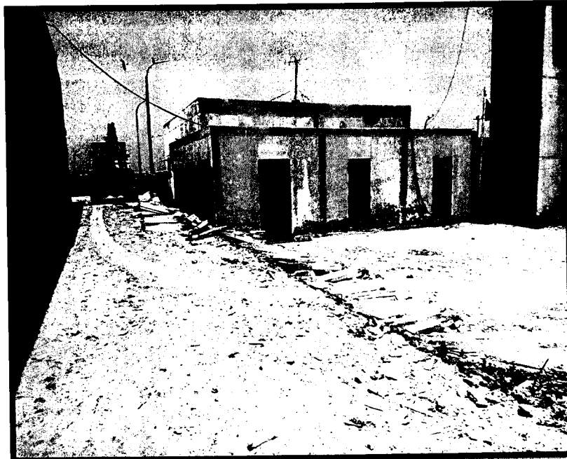
FOTOGRAFIA N°08. Demolición de Cerco Perimétrico en el Tramo 2
