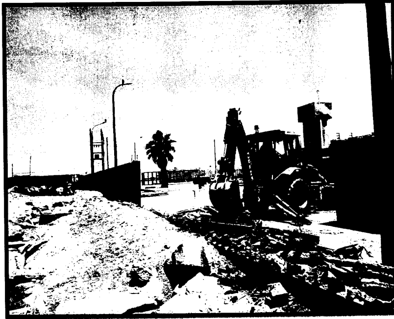
FOTOGRAFIA N°07. demolición de Cerco Perimétrico en el Tramo 4
